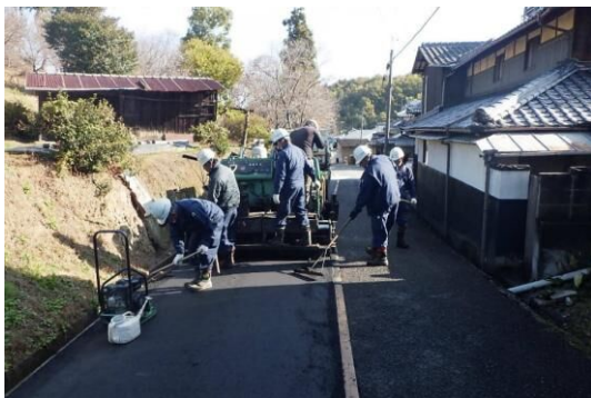
▲生活に直結する道路の修繕
