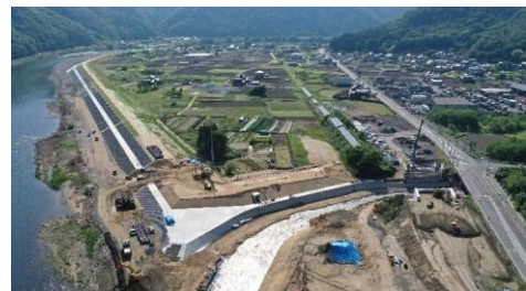
▲日羽堤防工事
