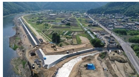
▲日羽堤防工事
