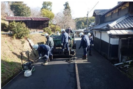
▲生活に直結する道路の修繕
