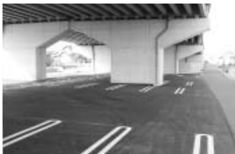
中原地内の高架下に整備された駐車場
