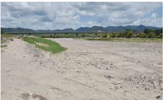
大量の土砂や流木で被害を受けた高梁川河川敷
