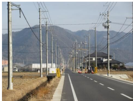
秦中央本線拡幅工事
