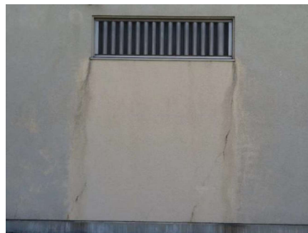
外壁ひび割れ（例）
