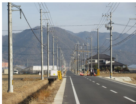
秦中央本線拡幅工事
