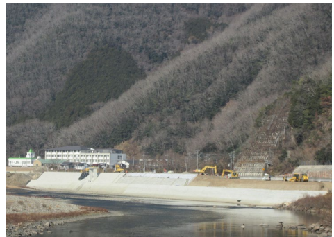
高梁川の堤防整備
