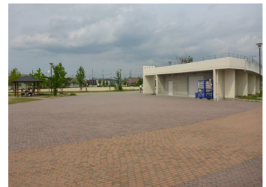
防災公園の機能を有する常盤公園
