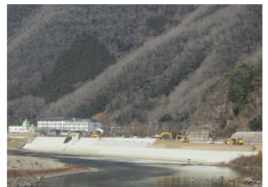
高梁川の堤防整備
