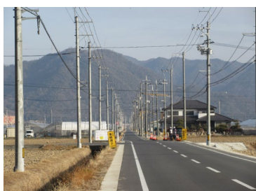
秦中央本線拡幅工事
