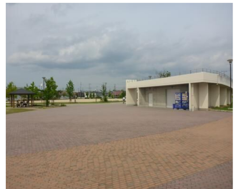
防災公園の機能を有する常盤公園
