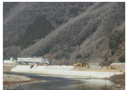
高梁川の堤防整備
