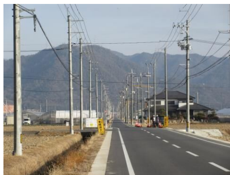
秦中央本線拡幅工事
