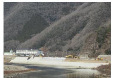
高梁川の堤防整備
