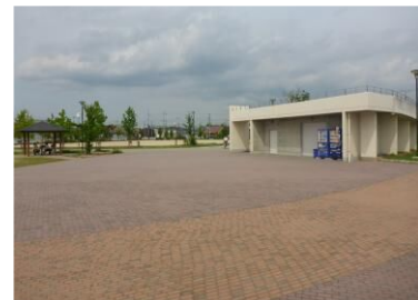
防災公園の機能を有する常盤公園
