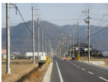
秦中央本線拡幅工事
