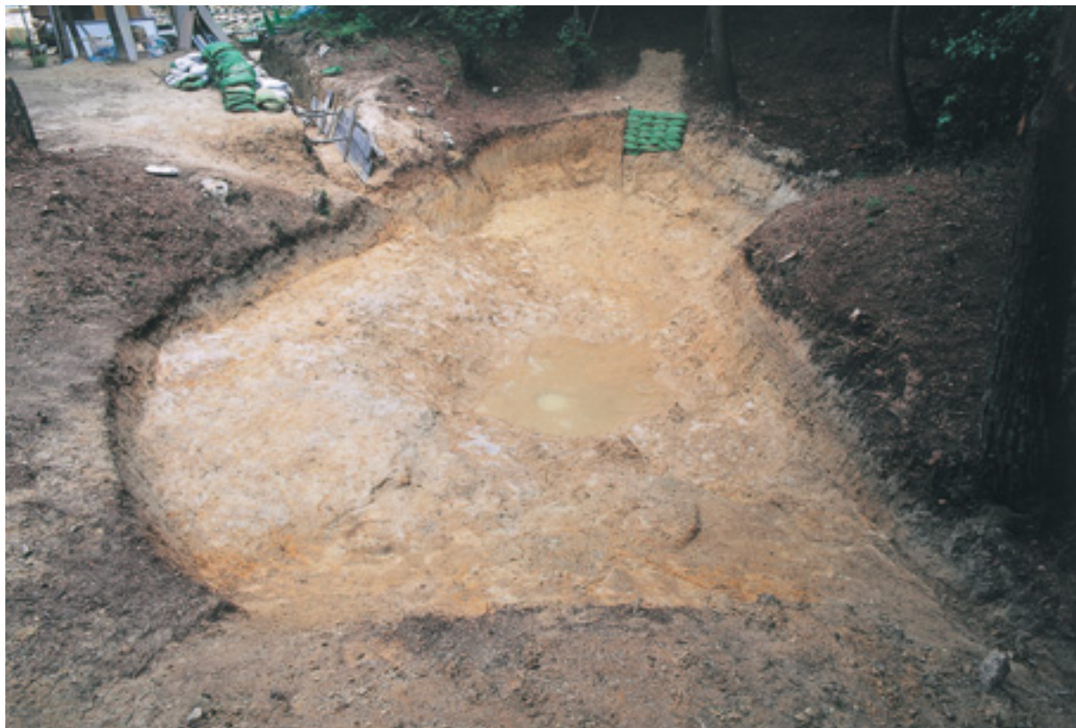
1. 第1水門 貯水池全景（東から）
