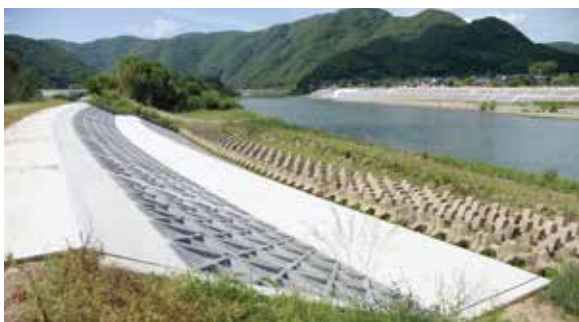
下倉地区草田の堤防。右奥の日羽地区でも築堤工事が進む
