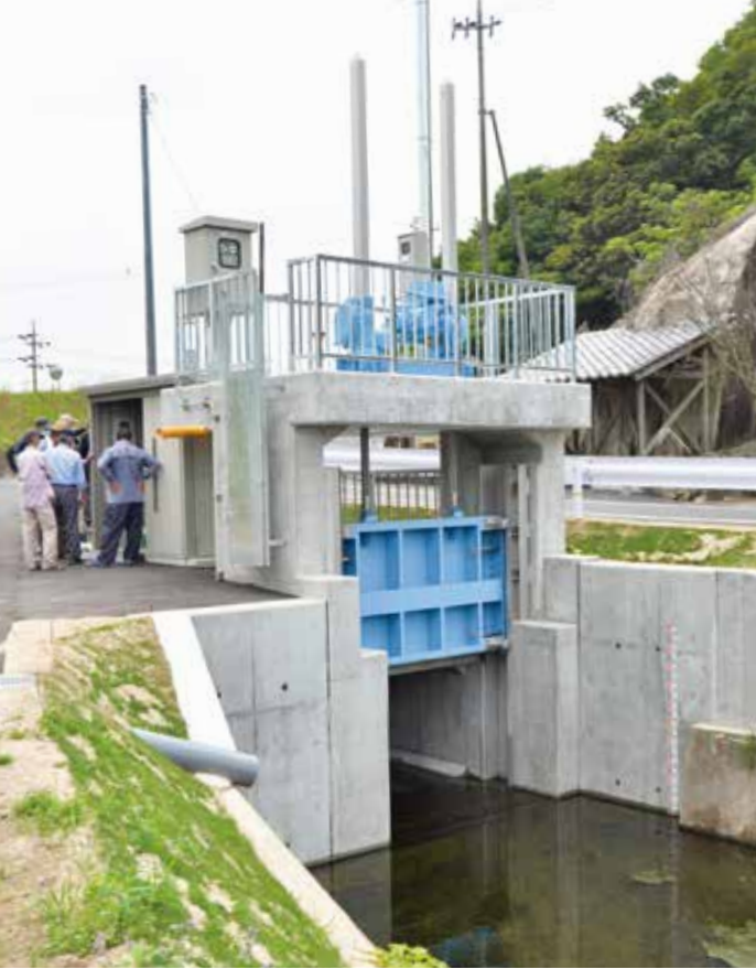
高さ5.4mの水門。作動時には青色のゲートが下りる
