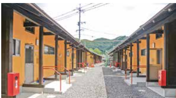
建物の基礎や外観、屋根を強化した復興住宅
