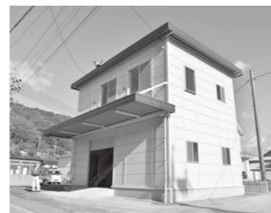
完成した下原地区の第2集会所
