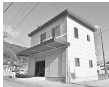
完成した下原地区の第2集会所
