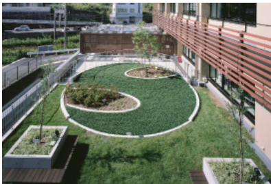
屋上緑化（志摩市庁舎）
