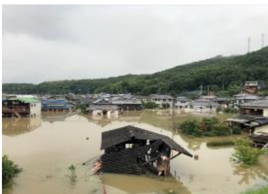
小田川からの浸水被害
