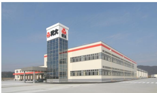
株紀文西日本 岡山総社工場外観
