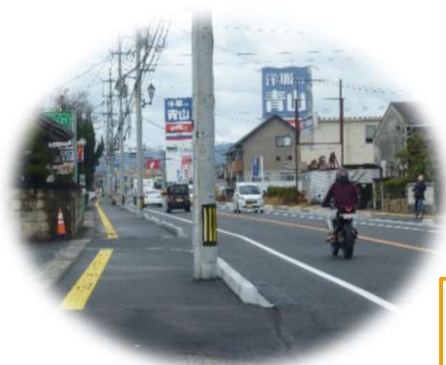
中央井手本線 自歩道フラット化事業
