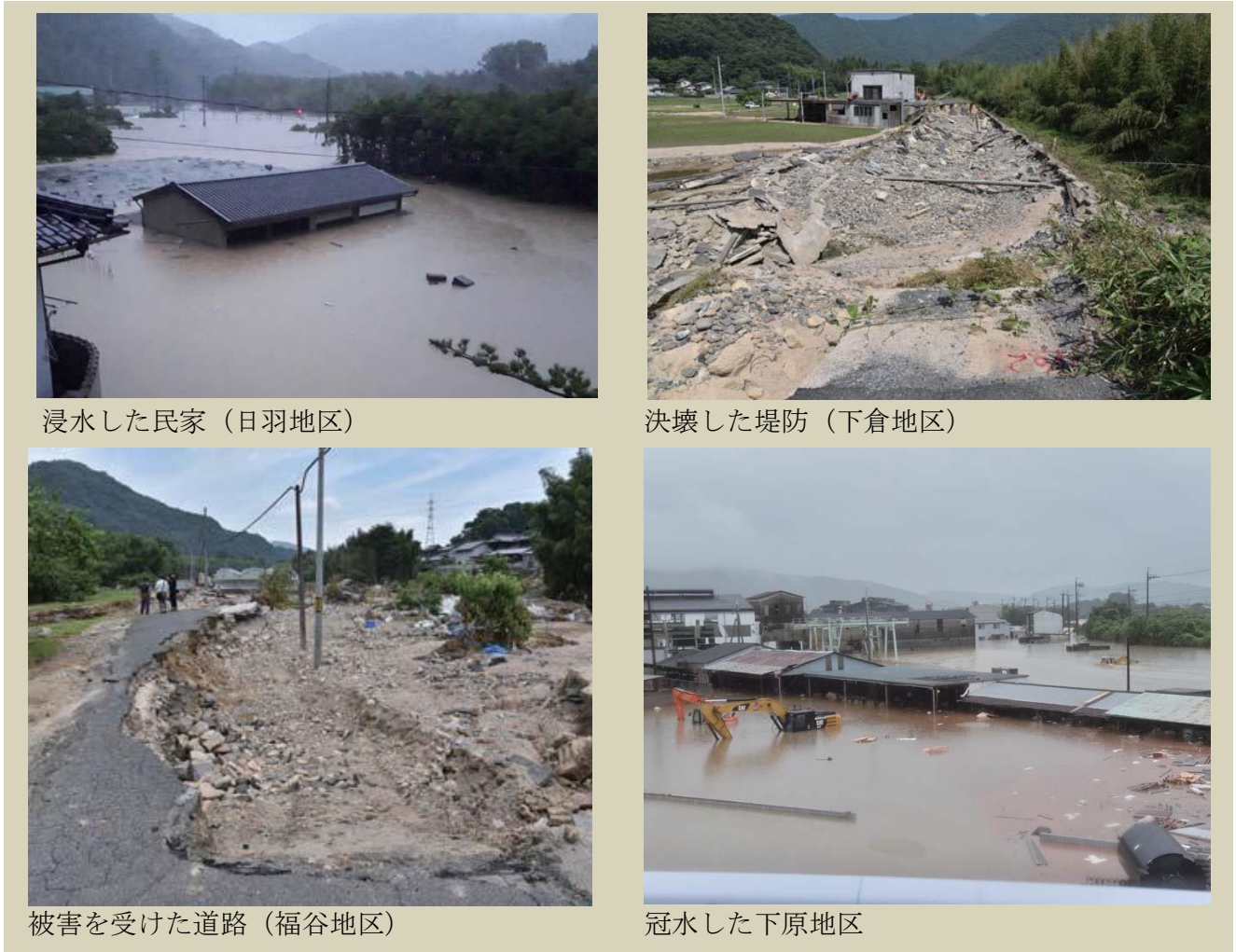
図2-1 平成30年7月豪雨災害による被害状況（発災直後に撮影したもの）
