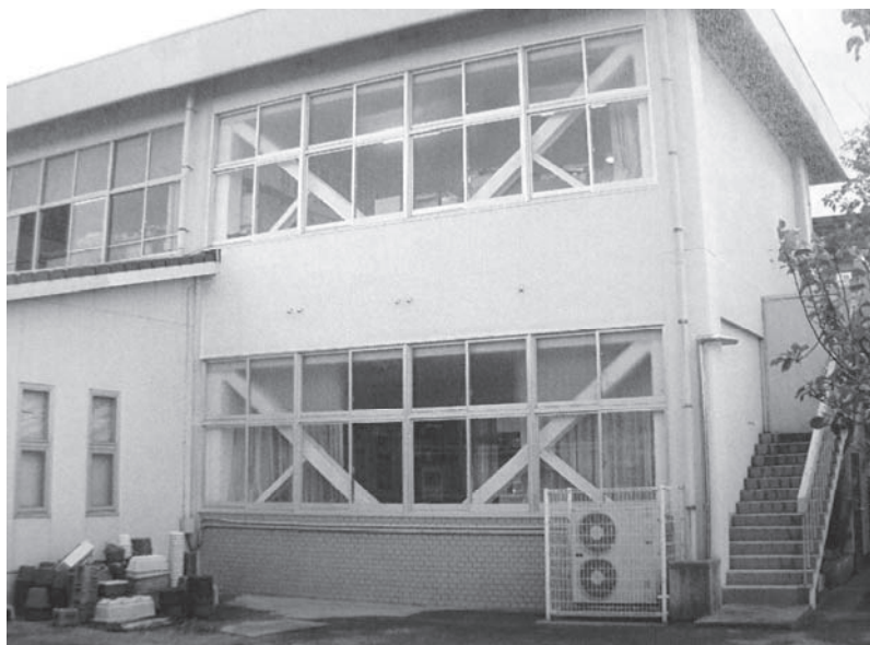
写真 16 耐震補強工事が完了した清音小学校管理・教室棟
