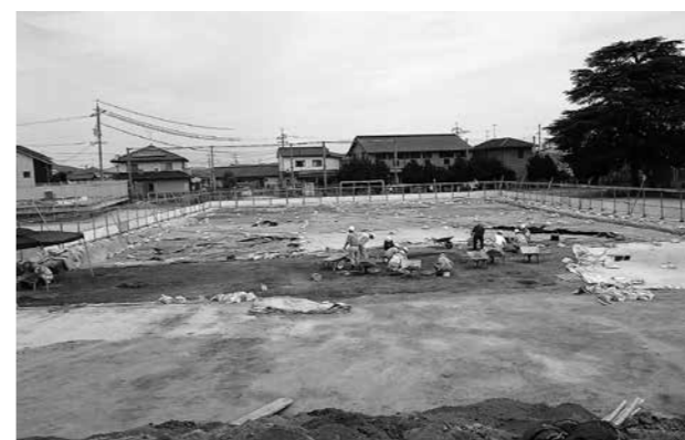
改築のための発掘調査中の総社小学校運動場
