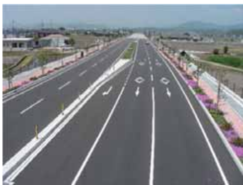
国道 180 号総社バイパス
