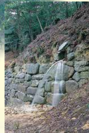
谷に築かれた水門
