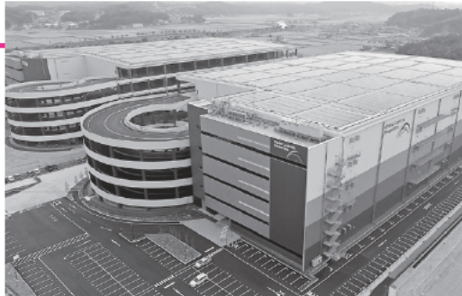
昨年11月5日にしゅん工式が行われたGLP岡山総社Ⅱ。北側では、日本郵便株式会社と日本郵便輸送株式会社の大型集配センターの建設が進む
