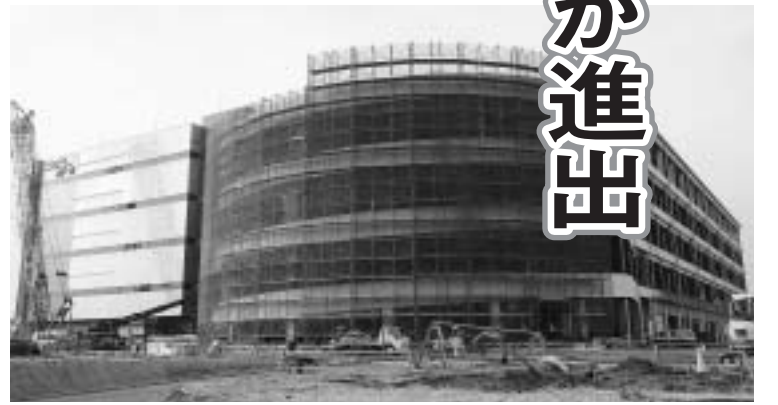
現在建設中のGLプロパティーズ株式会社が運営する予定の物流施設
