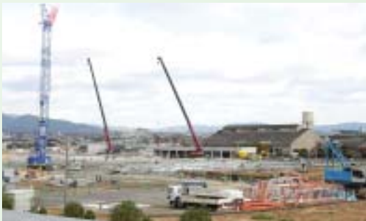
工事が進む中原地内のモンテール岡山・総社工場
