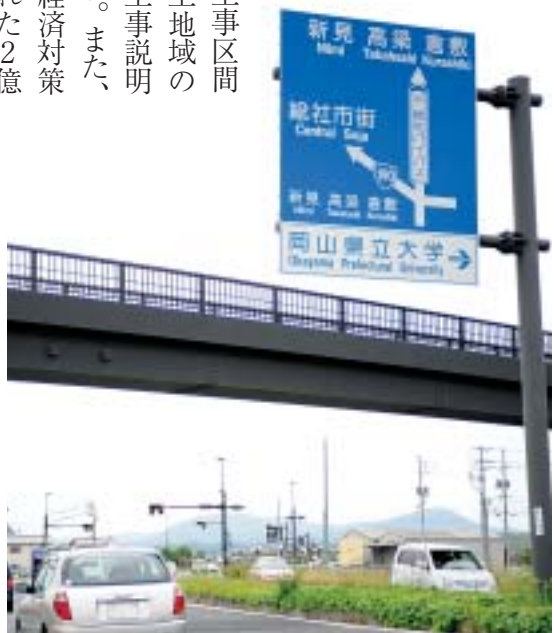
総社市窪木の岡山県立大学入口交差点付近
