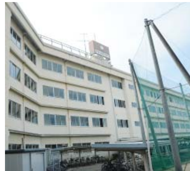
●総社西中学校校舎耐震化工事 1 億 5200 万円
