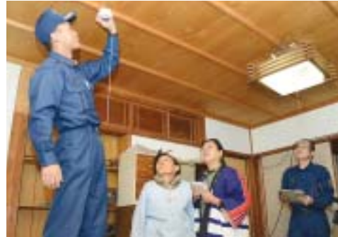
住宅用火災警報器を取り付ける消防職員
