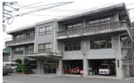
複合施設に建て替える計画の市昭和出張所。消防署昭和出張所の業務は、平成26年4月から移転新築される庁舎で開始する予定
