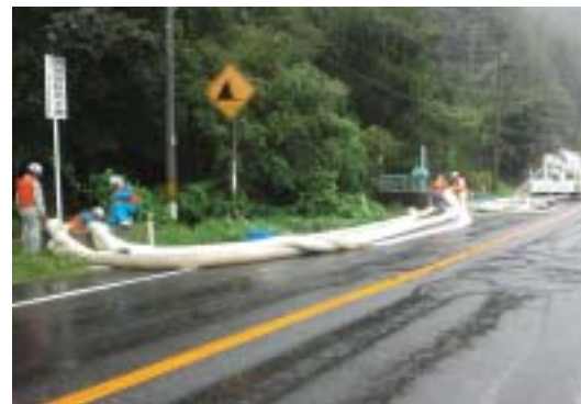
平成23年9月の台風の際は、国土交通省の排水ポンプ車に出動要請をした。市が排水ポンプを設置することにより、作原地区の内水を迅速に排水することができる
