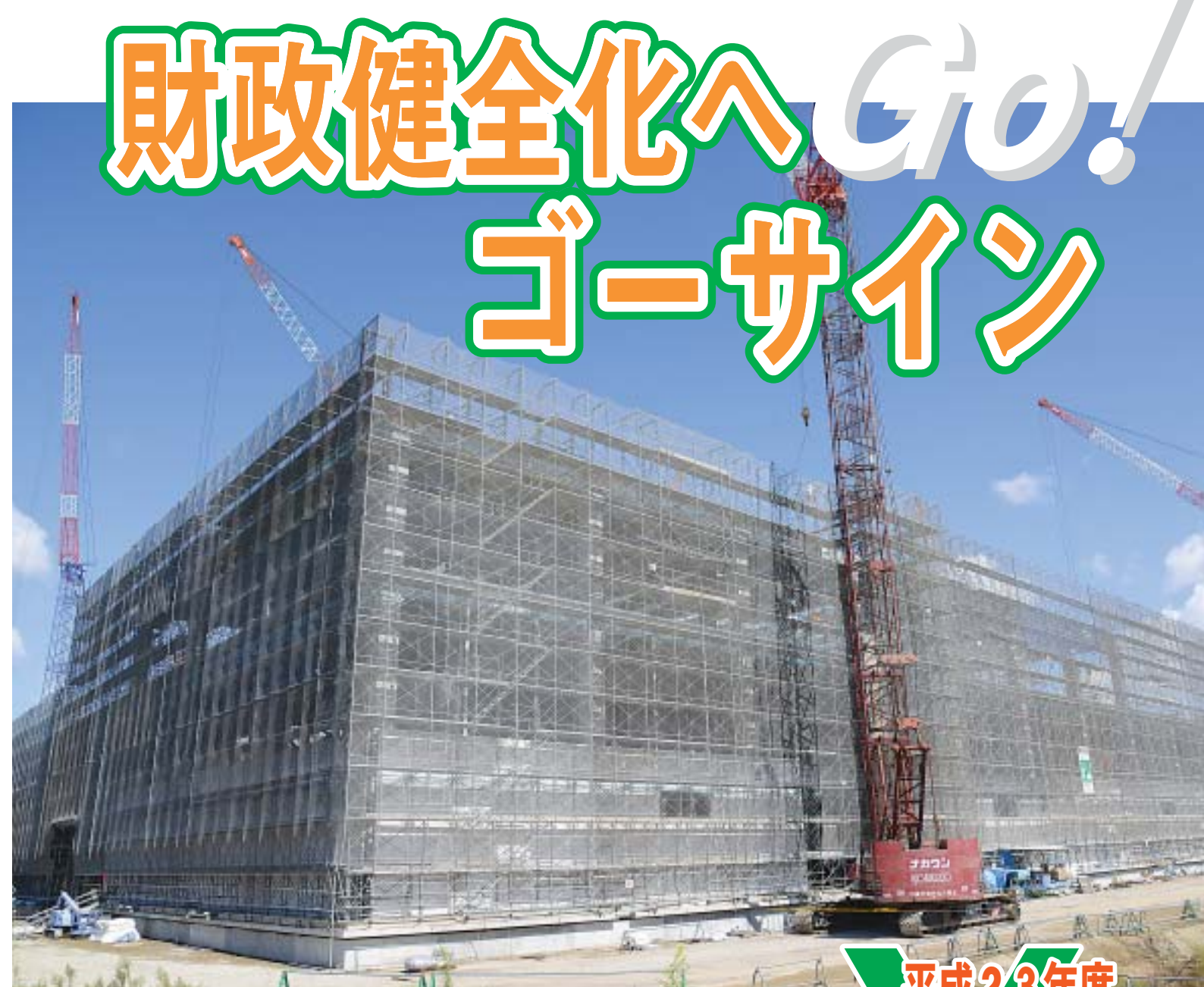
岡山総社IC流通センター(長良)地内に両備ホールディングス株式会社が建設中の物流施設。完成後はGLプロパティーズ株式会社が運営する
