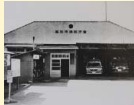
当時は1階建ての消防庁舎 [写真2]
