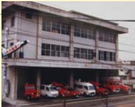
現市役所西庁舎にあった旧消防庁舎。約23年間その役目を担った
