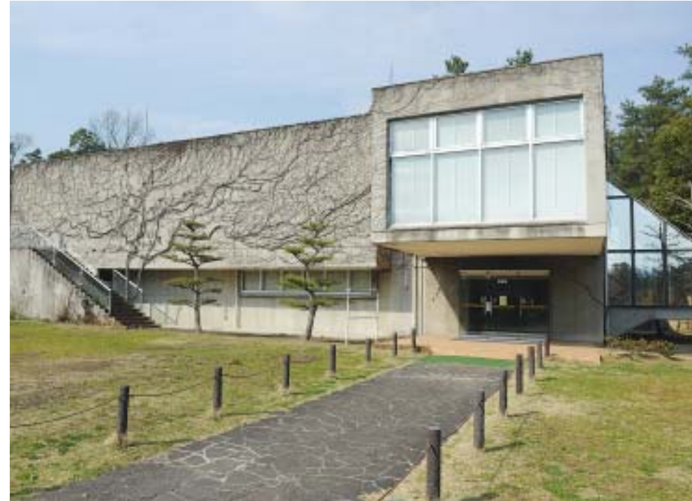
平成22年3月末に閉館した旧県立吉備路郷土館。備中国分寺の東約400mに位置する
