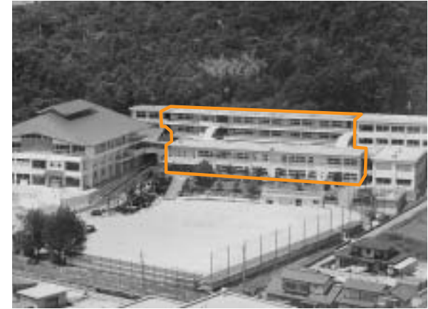
—で囲まれた範囲の校舎を解体し、手前の校舎の跡地に4階建の新校舎を建設する計画
