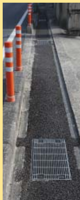
目の細かいグレーチングの設置と透水性の舗装がされた歩道
