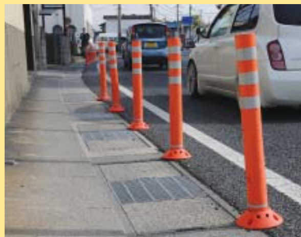
車道と歩道を分離するように設置されたポストコーン
