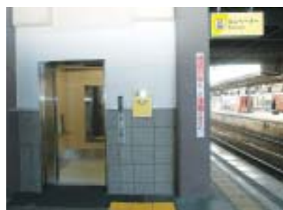
新設されたエレベーター
