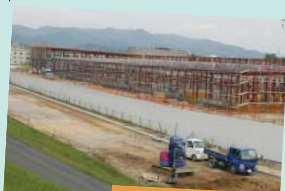
建設中の大阪富士工業の工場(中原)
