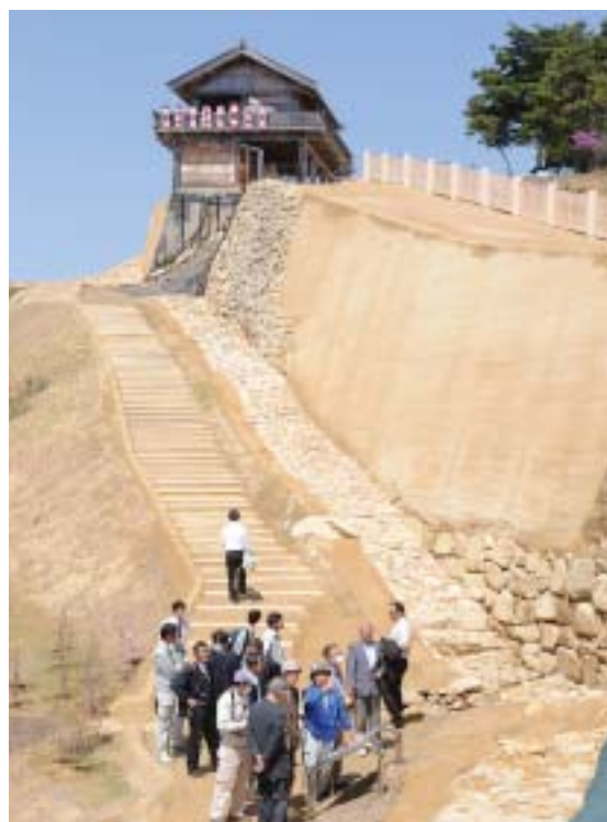
第0水門付近で整備状況を確認する委員ら。敷石や遊歩道、土塁上部の板塀などを見て回った
