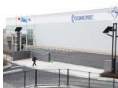
しゅん工した阿曾工場
