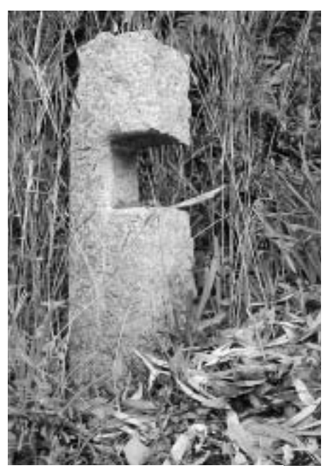
水害の水位の碑は、高さ約90cm、一辺約28cmの花こう岩の石柱。浸水した際の水位を今に伝える中央の開口部。地上から約50cm付近が、高さ約20cm奥行約12cmの大きさを削り取ってある
