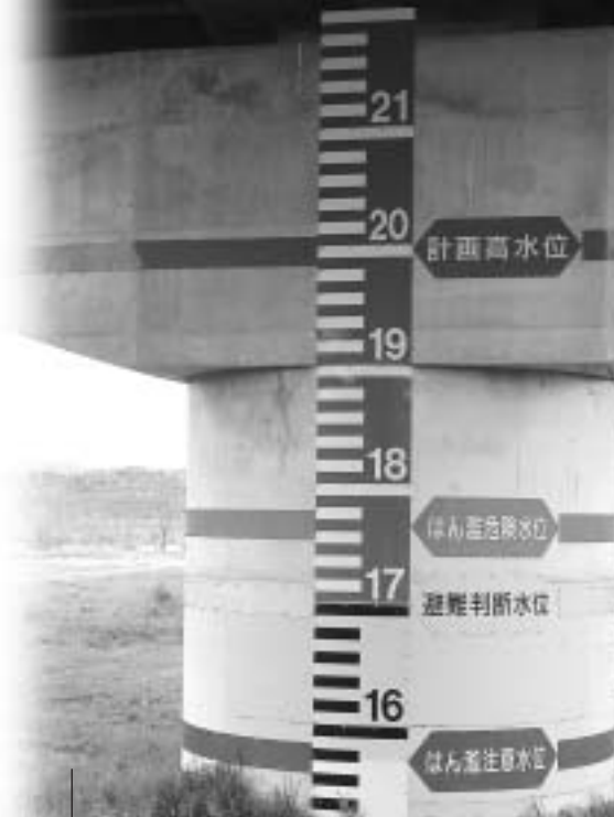
右の写真は、総社大橋の橋脚に表示されている洪水時の河川の水位を表す目盛り。警戒や避難の目安となる
