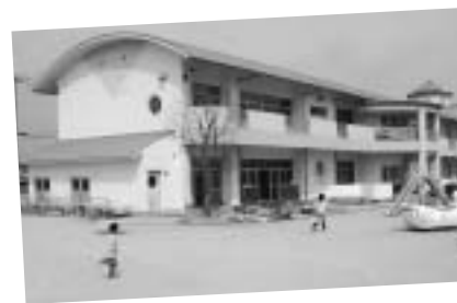
園舎を増築する常盤幼稚園。写真の左側に増築予定
