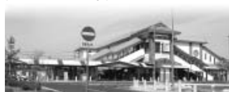
総社駅の上り方面のホームにエレベータを設置
