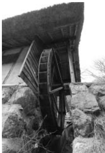
木造平屋建約30㎡の建物で、土壁やかやぶき屋根と本格的なつくりの水車小屋。壁に付けられた直径2mの水車が、谷川の水で回り、なかで精米ができるようになっている
