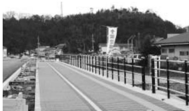
インターロッキング舗装と呼ばれるコンクリートブロックを整然と並べた工事中の国道180号バイパスの歩道。写真左側のレーンが自転車指定通行帯
