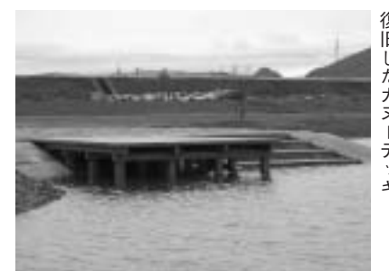
復旧したカヌーデッキ
