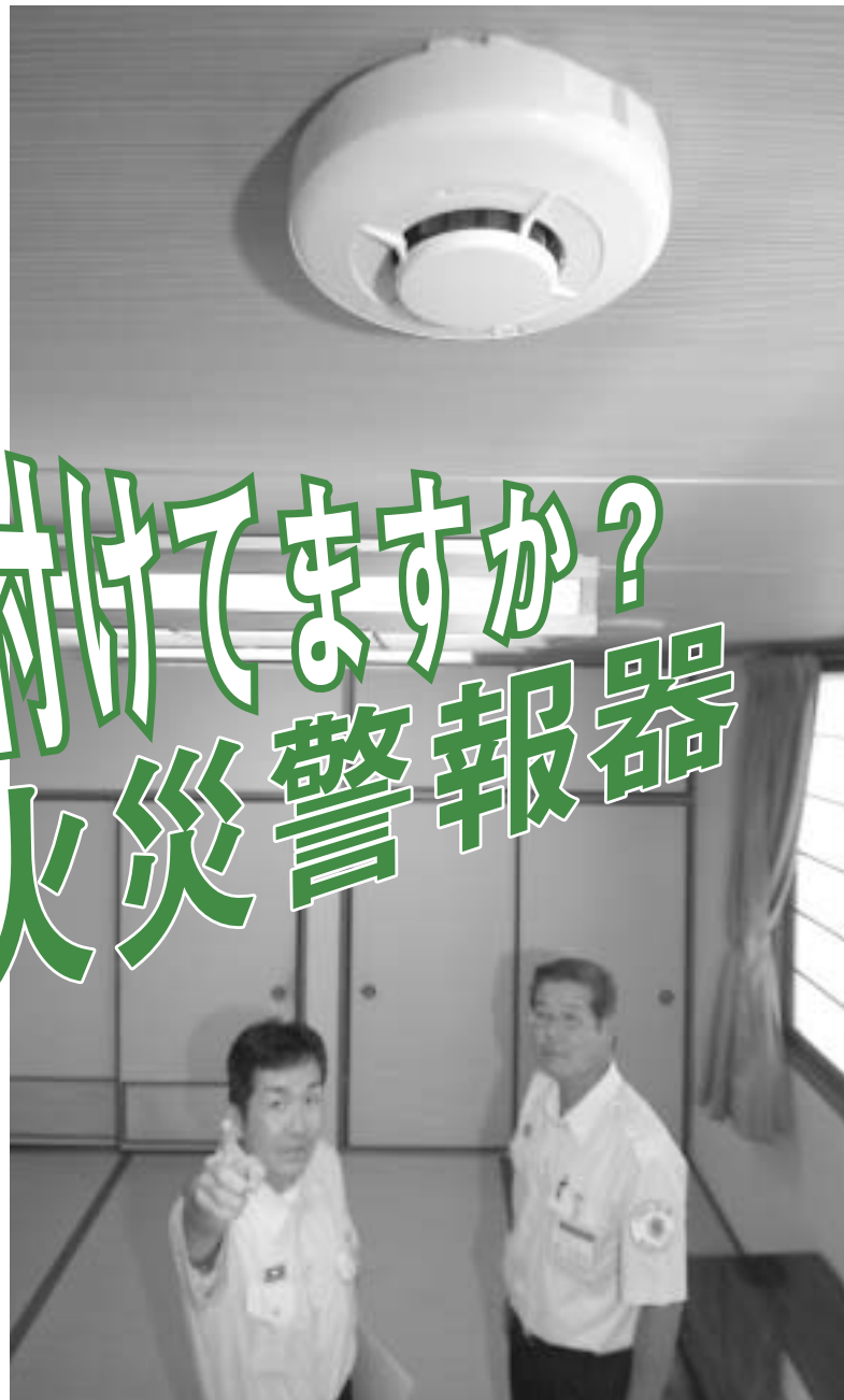
天井に取り付けられた火災警報器
