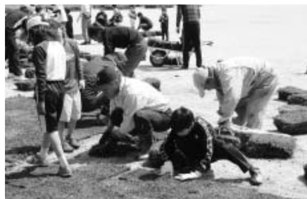
高梁川河川敷芝張り作業
