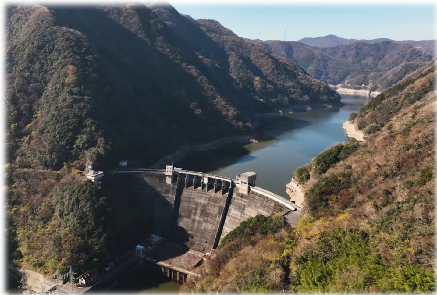
新成羽川ダム（岡山県 備中町）
