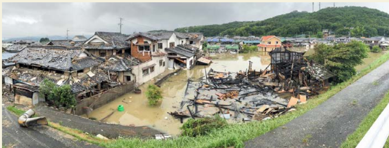
浸水したアルミ工場の爆発による被害(下原)
