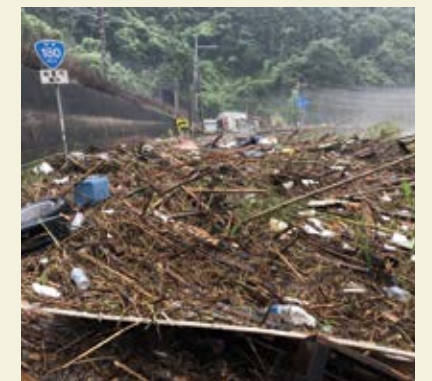
流されたガレキが堆積した 国道180号線(種井地区)
