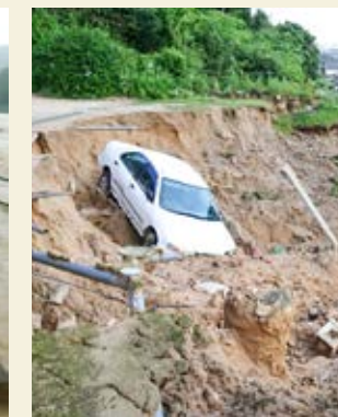
大雨による土砂災害(井尻野)
