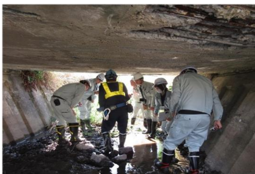
橋梁点検実習状況
